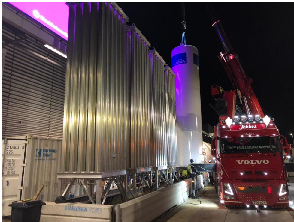
Anläggningen för medicinska gaser tar form och gastankar lyfts på plats redan i början av första produktionsveckan
